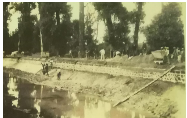
Travaux de réfection du canal après la guerre.
