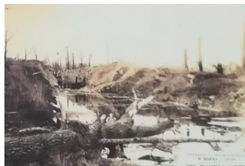
L'écluse détruite par la guerre 1914-1918, au début de la reconstruction.
